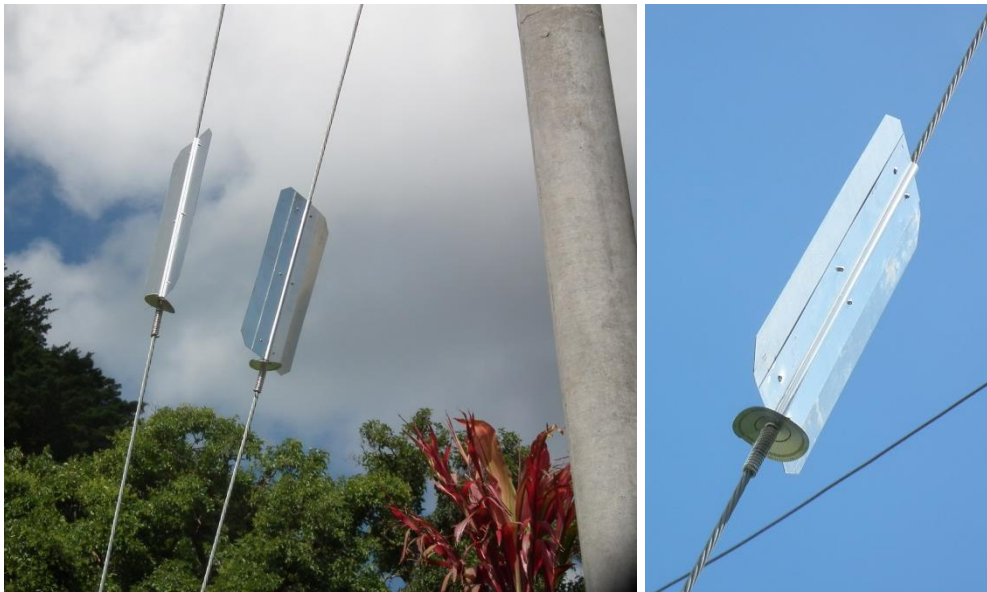
Figura 10. Dispositivo antiescalamiento tipo paleta, y su diseño (imágenes fuente CNFL).
