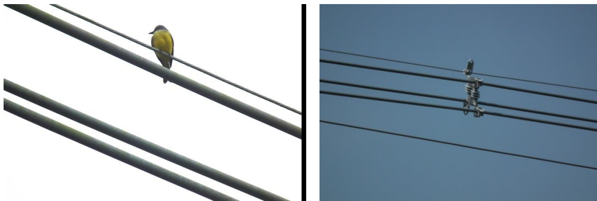
Figura 19. Cable conductor con recubierta semiaislada imágenes fuente CNFL).
